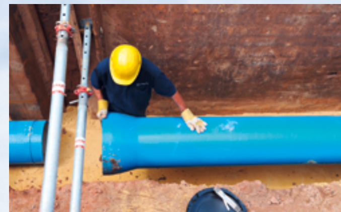
Verlegung einer Trinkwasserleitung
